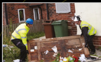
NETTOYAGE DE SITE
