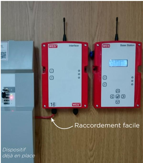
L'interface permet de connecter le système FIRE ALERT avec n'importe quel type de système tiers via un contact sec, ouvert ou fermé :
